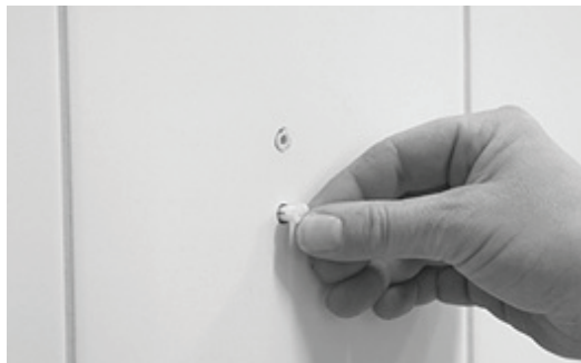
[ Bild 3.] Montera plastplugg avsedd för 5.5mm hål.
